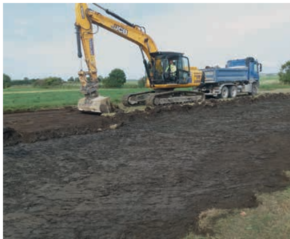
Baggerarbeiten zur Seigenanlage im September 2021.
