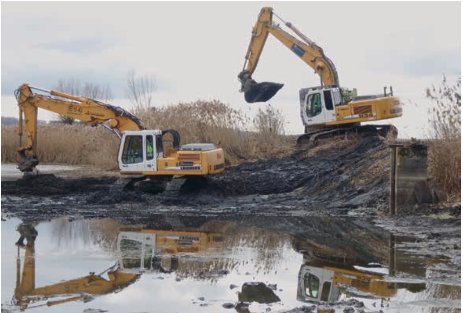
Schlammabnahme vor dem Mönch des Anhauser Weihers
