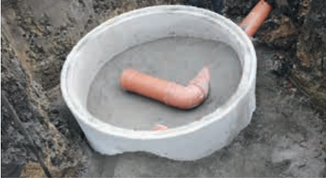
Einbau einer Wasserstandsregulation in das vom allgemeinen Drainagenetz abgekoppelte Drainagesystem auf Eigentumsflächen unserer Vereine in den Pfäfflinger Wiesen Foto: Lara Oblinger
