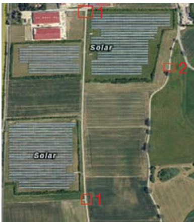
Luftbild der PV-Anlage Oettingen/ Munningen Geobasisdaten Bay. VV
