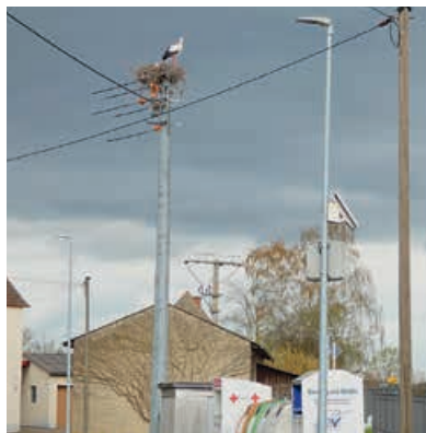
Fessenheim – Nest auf dem Strommast und an der Kreisstraße
